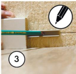
Собранную конструкцию из плинтуса и монтажной планки прикладываем к стене, в том месте, где планируется установка плинтуса. Отмечаем карандашом точку на стене и ведем конструкцию вместе с карандашом вдоль пола так, чтобы на стене получилась горизонтально начерченная линия.
