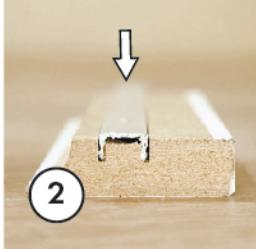
Отпиленный кусок монтажной планки вставляется в небольшой отрезок плинтуса таким образом, чтобы часть монтажной планки с отверстием под крепление выступала за пределы плинтуса.
