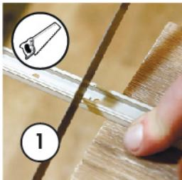
С помощью ножовки от монтажной планки отпиливается небольшой отрезок крепежной планки.
